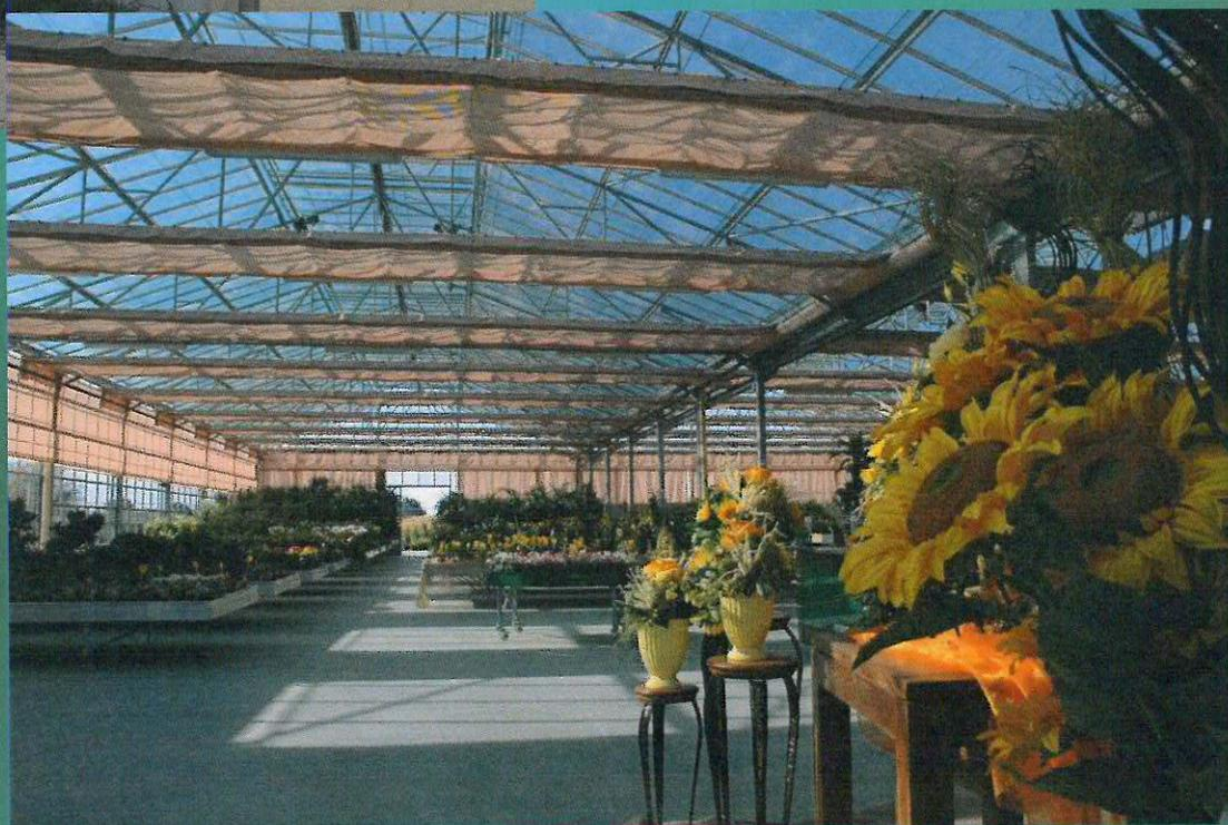
**Struttura:** Capriata a tutto sesto realizzata con brigle in tubolare di acciaio a sezione rettangolare, ragnatura in tubolare quadro e piastrame, il tutto zincato a caldo.
